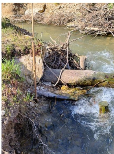
Beispiel 'Unterströmte Stammhölzer': Ausschwemmungen, Erosionen, angeschwemmtes Totholz und tiefe Kolke als Resultat der ersten (moderaten) Winterhochwasser einige Monate nach dem Einbau.
