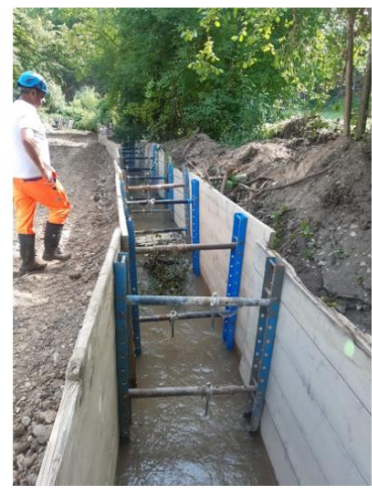
Rückbau und Umlegung Abwasserleitung an den Rand des neuen Gewässerraums.
