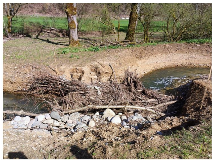
Beispiel 'Unterströmte Stammhölzer': Ausschwemmungen, Erosionen, angeschwemmtes Totholz und tiefe Kolke als Resultat der ersten (moderaten) Winterhochwasser einige Monate nach dem Einbau.
