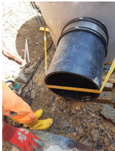
Rückbau und Umlegung Abwasserleitung an den Rand des neuen Gewässerraums.
