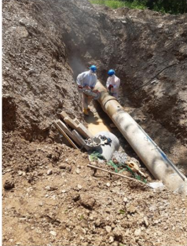
Rückbau und Umlegung Abwasserleitung an den Rand des neuen Gewässerraums.
